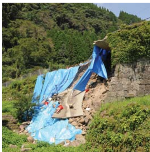
左は2014年3月撮影（熊本地震の2年前）の立門橋で、写真中央の石垣部分にはらみ出しがみられる。右は2021年8月31日撮影。西岸下流側のはね出した石垣の隅角部から西側の10mほどが崩落した 写真提供／中村まさあき
