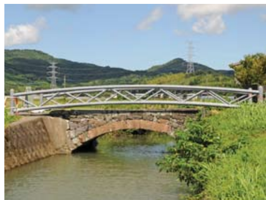
復旧した鴨籠橋
