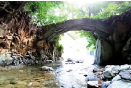
上流側から撮影したリブアーチの梯(掛橋)。左側が嘉麻地域、右側が小石原地域方面
