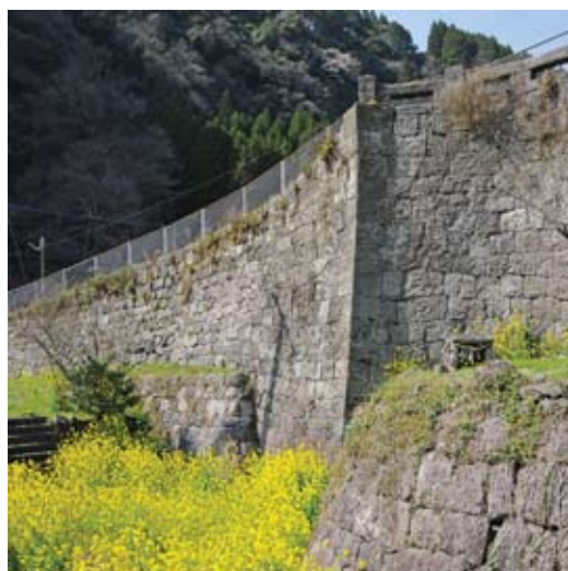
左は2014年3月撮影（熊本地震の2年前）の立門橋で、写真中央の石垣部分にはらみ出しがみられる。右は2021年8月31日撮影。西岸下流側のはね出した石垣の隅角部から西側の10mほどが崩落した 写真提供／中村まさあき
