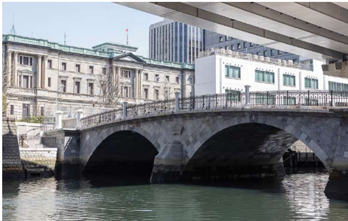
架設当時の美しい姿を取り戻した常磐橋。対岸は日本銀行本店
