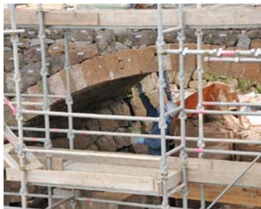
復旧工事中の鴨籠橋。創建時の石橋の輪石にもほぞ穴が空いた転用材が使用されている
