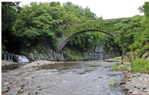
1924(大正13)年架設の出合橋。径間29.3mは日本で2番目の大きさ。橋長32.2m、橋幅3.9m、市指定有形文化財
