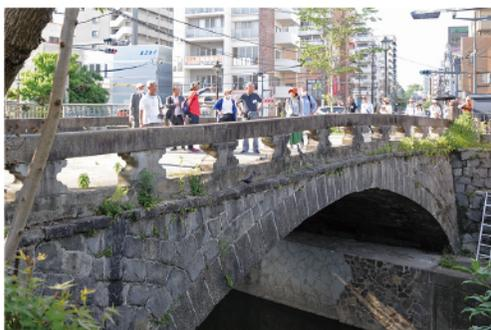
1875(明治8)年架設の明八橋。径間 21.4m、橋幅 7.2m。幅員が広く扁平なアーチが特徴。石工頭は種山石工・橋本勘五郎。高欄は創建時のものではないが、石橋本体は 1889 年と 2016 年の 2 度の大地震に耐え、現存している
