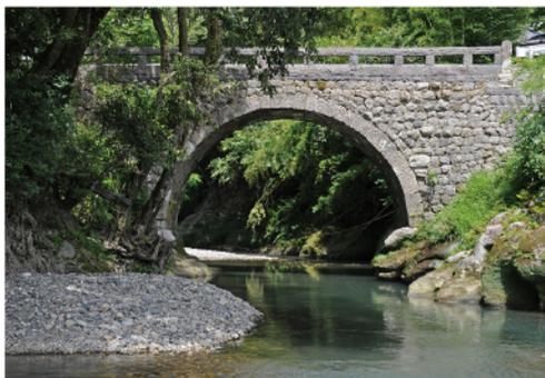
補修が終わった下町橋。1906年架設、橋長17.5m、橋幅3.25m、町指定有形文化財
