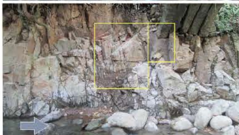
桑野の梯橋の応急保全工事着手前（上）と完成後（下）。岩盤の黄色枠が補強箇所（橋の上流・左岸側）。岩盤をステンレスアンカーを使ったロックボルト工法で補強し、擬石処理が表面に施された
