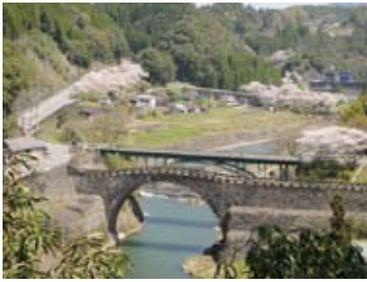
馬門橋は、輪石上の厚い盛土によって、外部から輪石が強く締め付けられており、安定しています。
