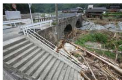
栗林橋（福岡・八女市） 土石流が大量に川に流れ込んだが、橋はよくその圧力と衝撃に耐えた（昨年8.12）
