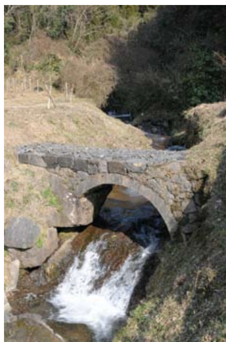
補修を終えた川内田堀切橋＊
