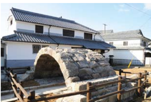
完成した須ノ前橋(2・10)*
