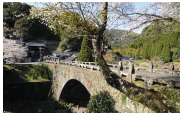
下鶴橋(熊本県下益城郡御船町) 写真提供/中村まさあき
