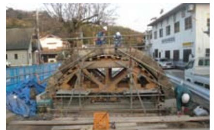
須ノ前橋復元工事風景。ジャッキアップした支保工の上に、解体され保存されていた輪石が積まれた(1.18)
