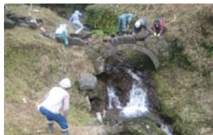
川内田堀切橋の補修工事中的風景（昨年10.27）
