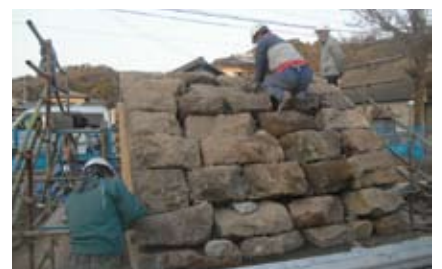
須ノ前橋の復元工事風景。輪石の位置を並べ替え、支保工の上に置いてみる作業が繰り返された(1.8)
