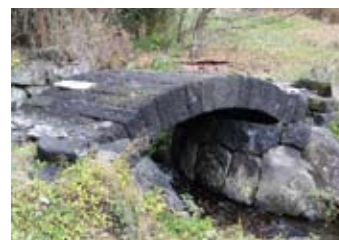
写真提供／中村まさあき 解体し石材を調整して 組み直した踊水橋
