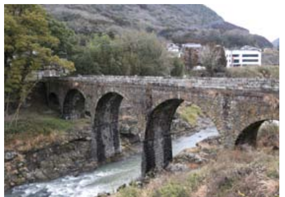
鳥居橋（県指定有形文化財） 1916（大正5）年架橋、石工棟梁は松田新之助、設計者は都留清一郎、細く高い橋脚が優美な布積みの5連アーチ
