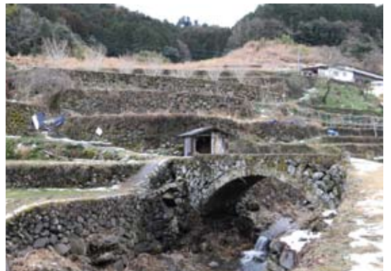
両合川橋（国登録有形文化財） 1925（大正14）年架橋、棚田の風景に溶け込む単一アーチ 壁石は棚田の石垣と同様の自然石の乱積み
