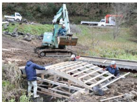
花蓮橋の支保工架設の様子 =2013年12月
