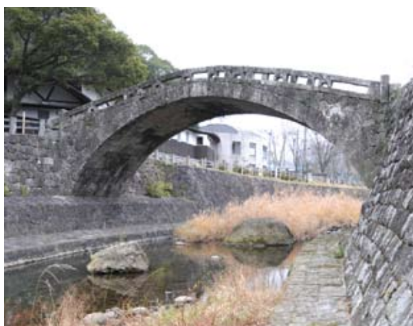
重盤岩目鑑橋(熊本県津奈木町) 写真提供/中村まさあき
