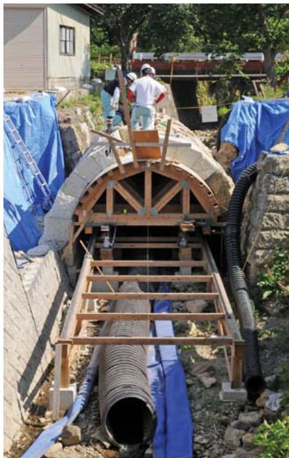
工事中の小巖橋(下流側)。白っぽい輪石が新材(高畠石)。支保工は6点でジャッキアップされ、抜き差し用のレールが設置されている(*b)
