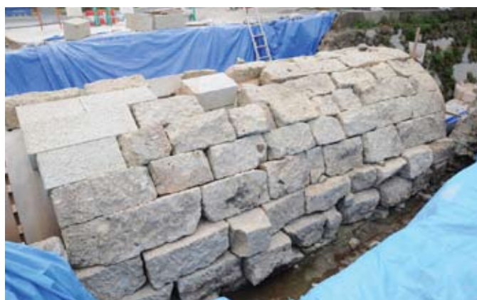
石材の位置確認のため、支保工の上に仮置きされた輪石(2015年8月9日)。旧材の輪石基底部の高さが水平にそろっていない(*a)
