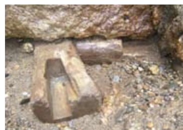
胴木は2列のはしご状になっていたようだが、1列は流失したとみられ、短い横木が残っていた(*a)
