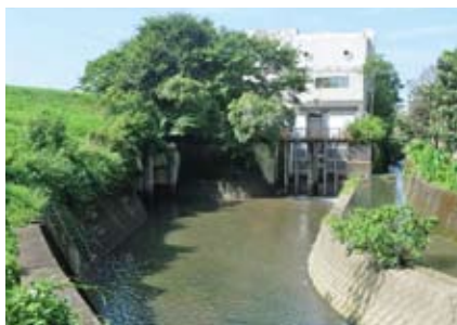
写真5 高瀬裏川放水路(熊本・玉名市) 余分な水を左側へ放水。正面がポンプ場
