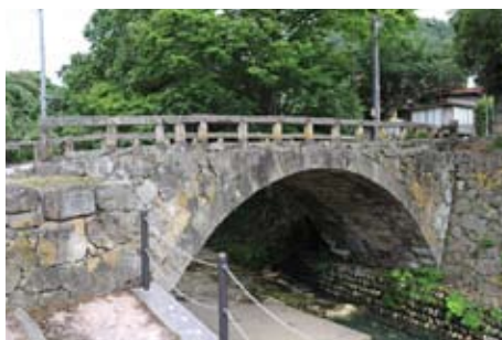
新橋。上山市柵下、明治13年架橋、橋長14.7m、橋幅4.4m、径間約12m、上山市指定文化財
