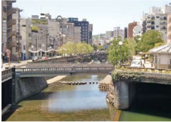
写真1 中島川バイパストンネル(長崎市) 前方左右がバイパスの入口。後方2橋目が眼鏡橋
