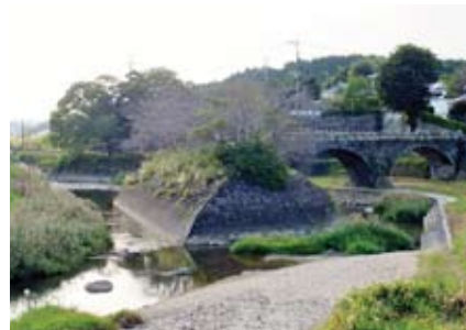
写真2 岩本橋(熊本・荒尾市) 左岸側に河川バイパスが整備され周辺は公園に
