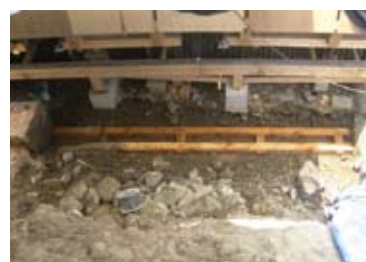
残っていた胴木に松の新材をつなぎ、はしご状に組んで基礎石の下に設置(*a)
