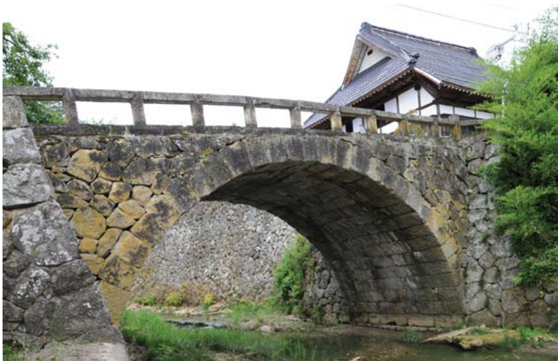
硯橋(のぞきばし) 山形県上山市榎下、1882(明治15)年架橋、橋幅3.5m、径間約8.4m 石材は大門石(凝灰岩)、上山市指定文化財 写真提供/中村まさあき
