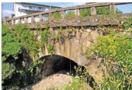
中山橋。上山市中山、明治13年架橋、橋長11.3m、橋幅6.7m、上山市指定文化財
