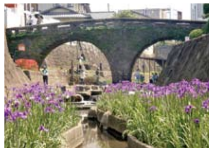
写真4 高瀬目鏡橋(熊本・玉名市) 上流の放水路整備により、現位置保存が可能に
