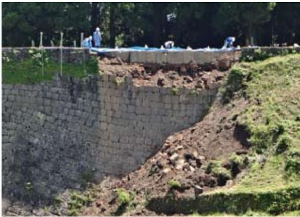
大雨により上流右岸側の鞆石垣の上部が崩落した通潤橋
