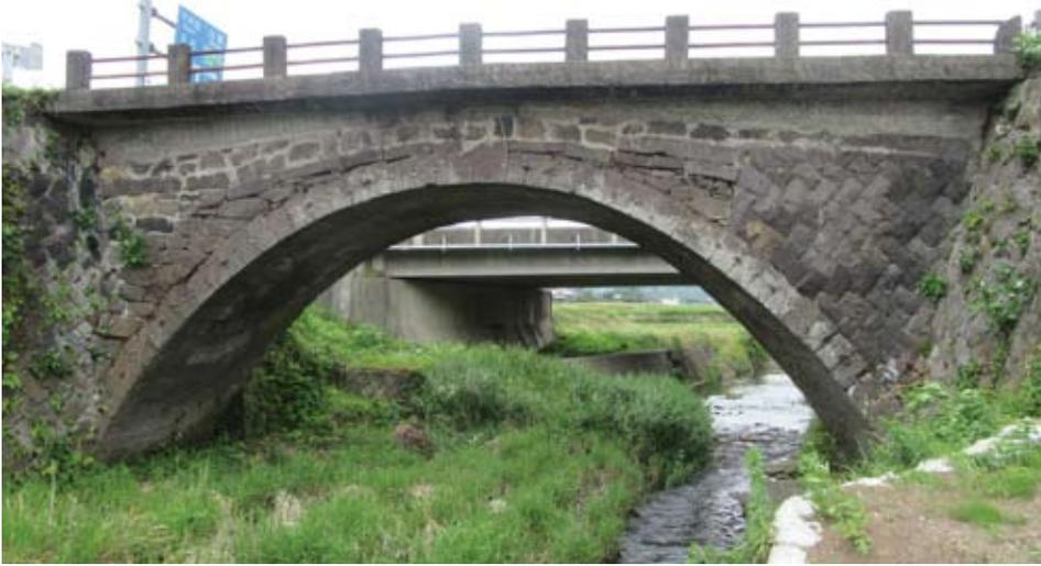
豊岡橋の downstream 側。輪石が小さな丸いだぼ石で連結されている。壁石の積み方が左右異なり、輪石上部はコンクリートを使って改変されている
