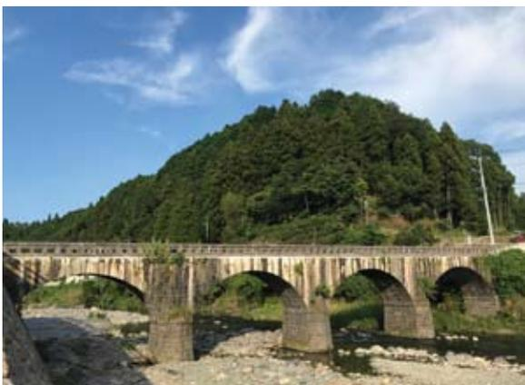
宮ヶ原橋の下流側。高欄復旧後のたびたびの雨でセメントが流れ、その跡が白く壁石に残ってしまった 写真提供／内田理絵
