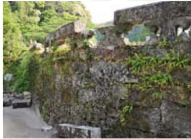
上流右岸側の下鶴橋の高欄。左は震災で崩落した高欄（2016年5月2日撮影）。右は一部の手すり石とそれを支える束柱（つかばしら）が新材に交換され復旧（今年8月5日撮影）
