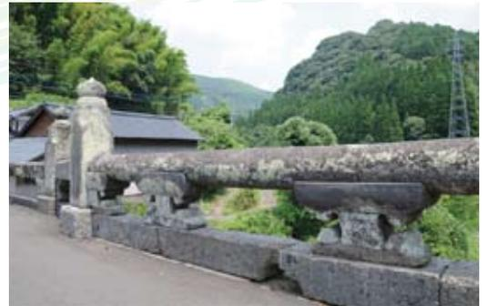
上流左岸側の下鶴橋の高欄。風化や損傷した束柱が修復され、円筒形の手すり石の下に据えられた。路面の修復により、震災までアスファルトの下に埋もれていた束柱の下の縁石が姿を現した（今年8月5日撮影）
