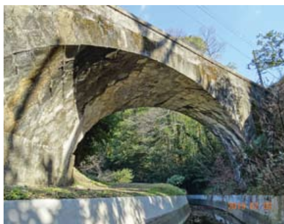
六把野井水拱橋＝三重県いなべ市員弁町
