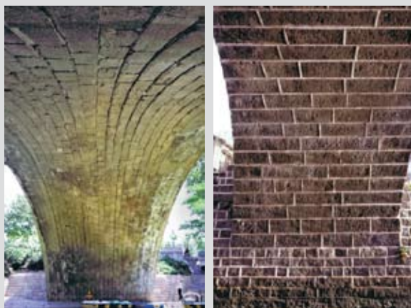
写真左は、中国・河北省石家庄市趙県の「趙州橋」（橋長50.8m、橋幅約10m）のアーチ。架橋は隋時代の605年。細長い輪石28列が積まれている。右は、日本の長崎眼鏡橋のアーチで、長崎大水害（1982年）以前に撮影 写真提供／榊 晃弘
